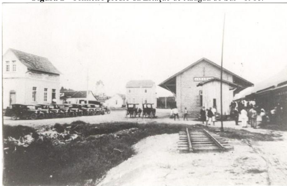
Figura 2 – Primeiro prédio da Estação de Jaraguá do Sul - 1910.
