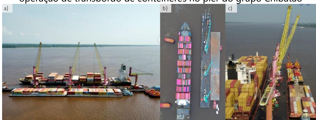
Figura 7 - Funcionamento dos portos flexíveis: a) porto com navio e barcaças atracadas; b) porto da empresa Super Terminais; c) operação de transbordo de contêineres no píer do grupo Chibatão
