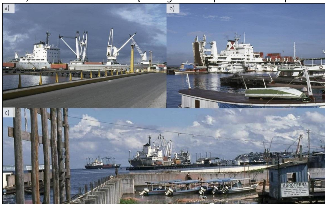
Figura 4 - Porto de Manaus: a) guindaste do navio realizando o descarregamento dos contêineres no porto; b) navio atracado com contêineres; c) navio e demais embarcações regionais na proximidade do porto
